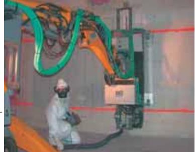
« Décapage » téléopéré des murs
