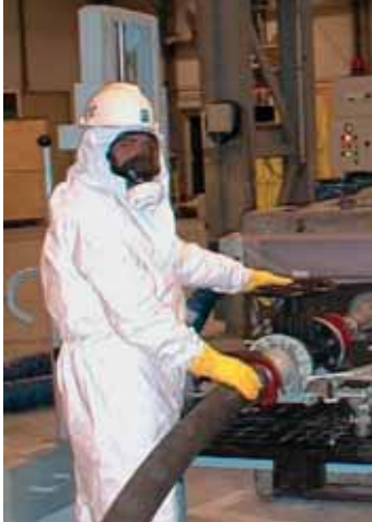
Opération d'injection de béton
