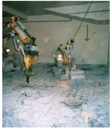
Retrait des épaisseurs contaminées du sol
