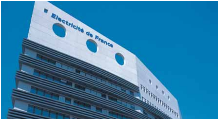
Siège EDF Branche Production ingénierie à Saint-Denis
