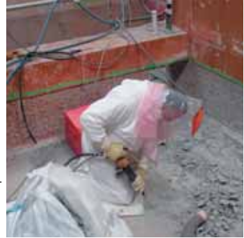
Assainissement d'un local
