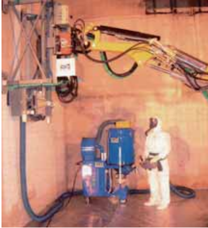
« Décapage » téléopéré des murs
