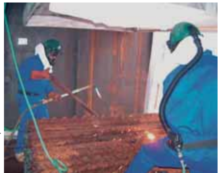
Travaux de découpe
