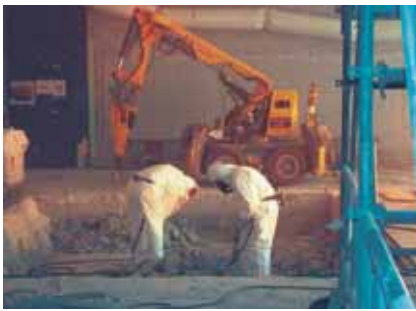
Assainissement de sol
